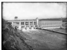
La construction de l'usine hydro-électrique binationale de Chancy-Pougny entre 1919 et 1925 s'inspire des nombreuses «cathédrales électriques» érigées durant l'Entre-deux-guerres. Dès 2004, des travaux de rénovation ont permis de moderniser l'appareil de production tout en conservant la dernière turbine Francis vieille de plus de 90 ans.
