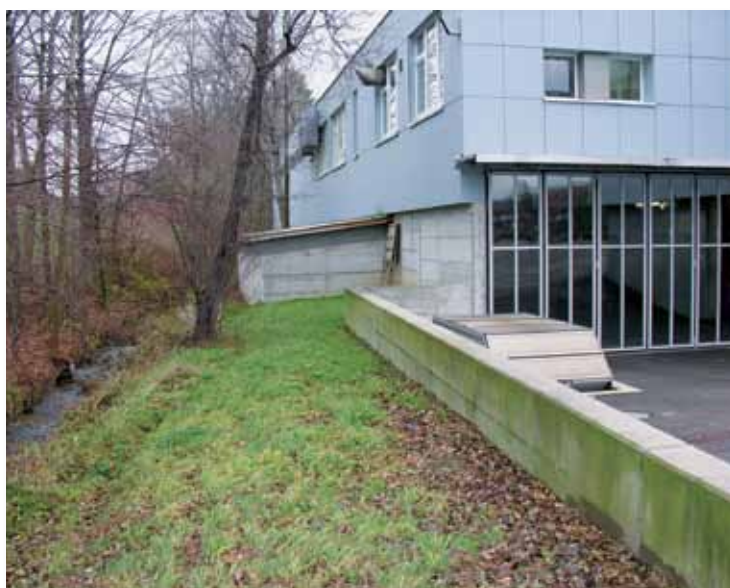
Protection d'un entrepôt de produits chimiques contre les crues (Photo: Office de l'environnement, canton de TG)
