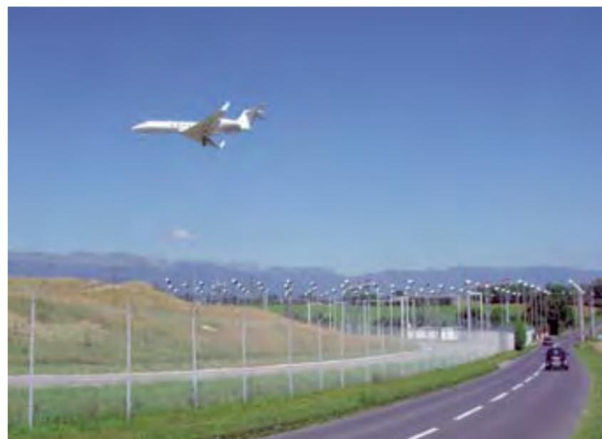
Le « sol artificiel » (balises) guide les avions à l'atterrissage.
