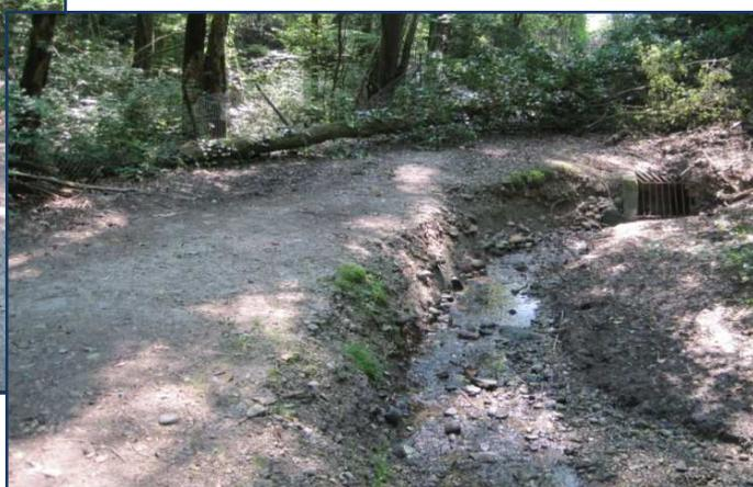
**Figure 2 :** Erosion du chemin de la Fermette par le Crève-Coeur.
