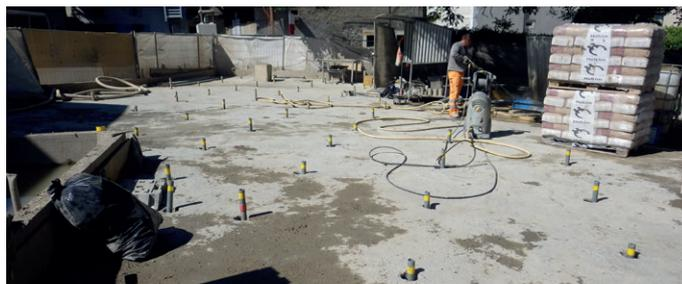
Travaux d'injections (renforcement du sol) de la cour de la Ferme Tissot
