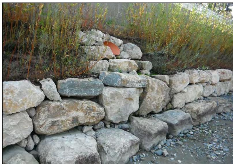
Exutoire situé au-dessus d'une stabilisation de rive en enrochements qui joue également un rôle de dissipateur d'énergie secondaire. De part et d'autre de l'ouvrage la rive est stabilisée au moyen de lits de plançons qui vont à terme favoriser l'intégration visuelle de l'exutoire.
