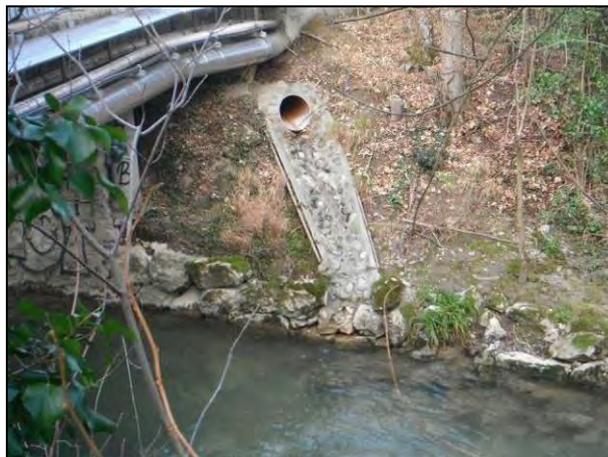
Outre une mauvaise intégration visuelle, les exutoires en toboggan lisse n'assurent pas une bonne dissipation de l'énergie et favorisent les affouillements au point de rejet dans le lit des cours d'eau.
