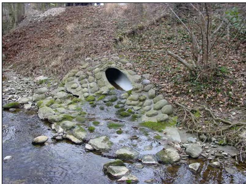
Exutoire intégré dans une lentille en boulets bétonnés. Une stabilisation en génie biologique aurait permis d'éviter de dénaturer la rive et aurait été moins onéreux. De plus, la partie bétonnée provoque une perturbation hydraulique qui va, à terme, créer des érosions du lit et de la berge.
