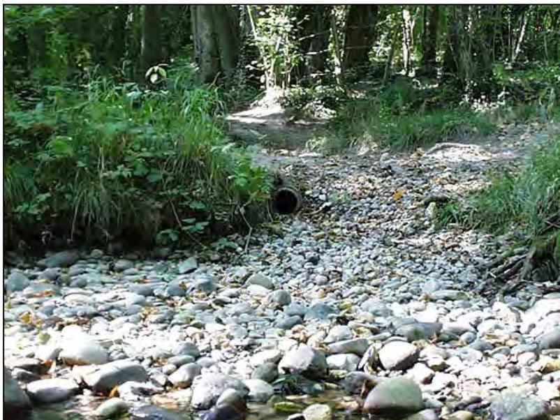
Exutoire en retrait du lit mineur, à peu près au niveau des hautes eaux moyennes. Les écoulements s'infiltrent et ruissellent sur une plage alluvionnaire avant de rejoindre le cours d'eau récepteur. La situation est bonne du point de vue de l'intégration visuelle et favorise l'infiltration.
