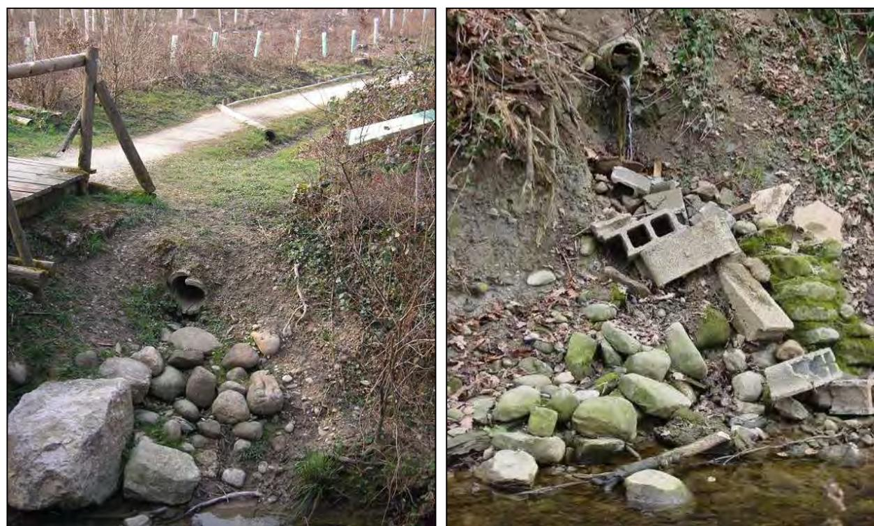
En absence d'un système de dissipation d'énergie secondaire et d'une stabilisation de la rive, des exutoires perchés peuvent provoquer des érosions de rive.
