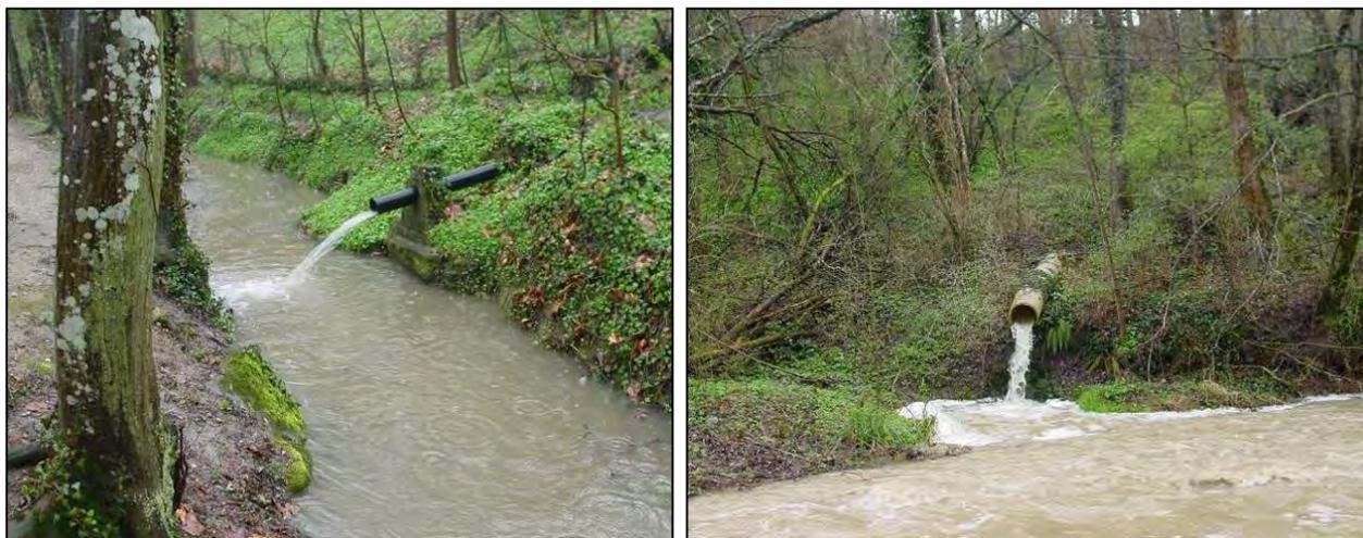
Les exutoires situés au-dessus du niveau des hautes eaux moyennes, sans dissipateur d'énergie et dont la pente est trop importante provoquent des érosions de rive et des affouillements dans le lit des cours d'eau.
