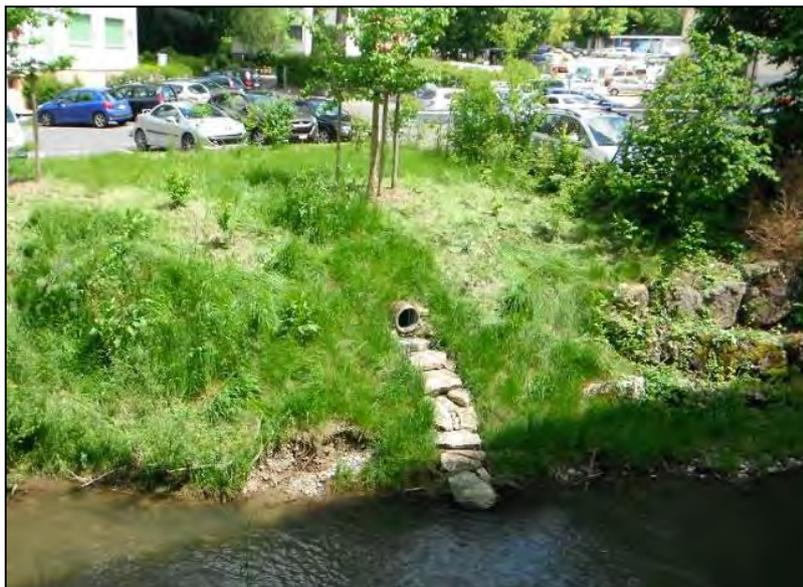
Pour un exutoire hautement perché, un dissipateur d'énergie secondaire permet d'éviter l'érosion de la rive sous le rejet. Dans ce cas, le dissipateur sous forme d'escalier en blocs remplit sa fonction mais des plantations arbustives auraient amélioré son intégration visuelle et sa stabilité.
