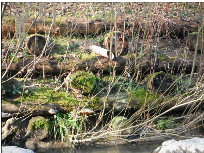
Exutoire intégré dans un caisson végétalisé. Le système racinaire des boutures de saules qui se développent sur l'ouvrage doit assurer sa stabilité à long terme. Avec le temps, les végétaux vont poursuivre leur développement et la rive va prendre un aspect de plus en plus naturel.
