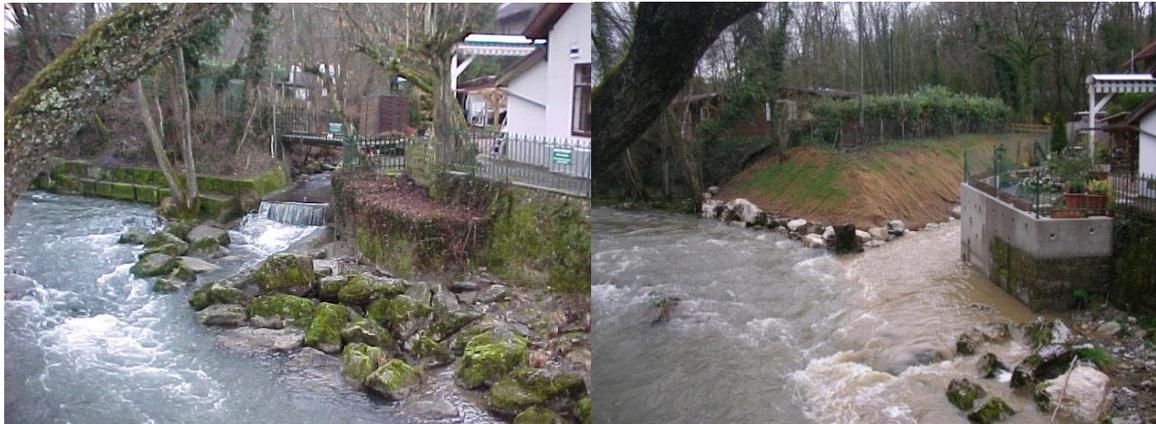
Figure 13: Exemple d'une intervention de renaturation couplée à de la protection contre les inondations à l'embouchure du Creuson dans la Versoix (gauche avant ; droite après) Suite aux travaux, le cours d'eau reste dans un état écomorphologique non satisfaisant. Néanmoins,, le Creuson a été reconnecté biologiquement à la Versoix et les constructions situés sur la berge en rive droite assainies.
