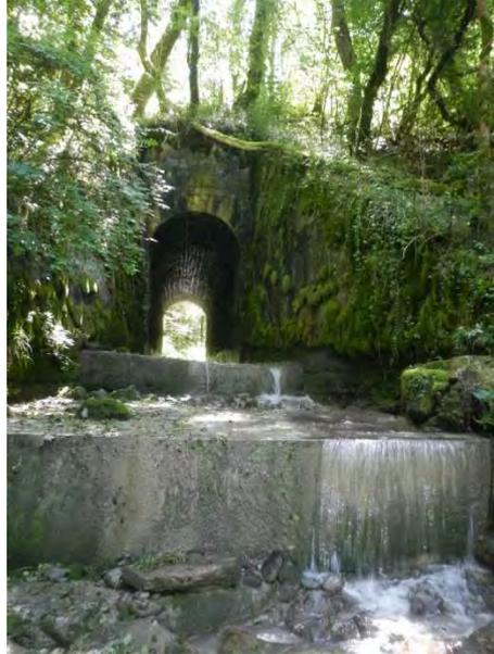
Figure 150. Double seuil sous le pont de la route de Vers-Vaux.
