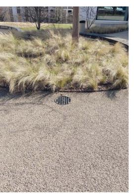
Figure 2 : aménagement ne permettant pas à l'eau de pluie d'attendre un arbre nouvellement planté (photo : Gaëtan Seguin).
