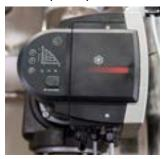
Un commutateur à paliers permet de régler le mode d'exploitation de manière fixe (pompe non modulable). Plus la vitesse est élevée, plus la quantité d'eau pompée est importante.
