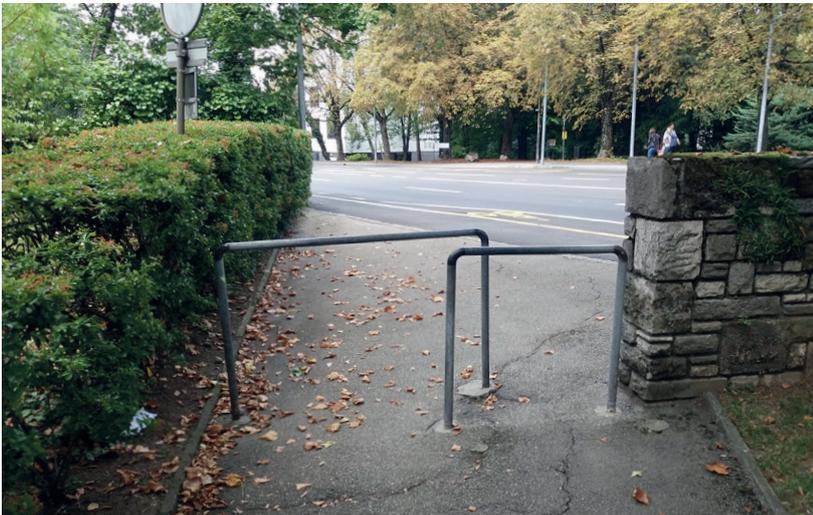
Figure 16: Chicane non conforme sur un chemin piéton
