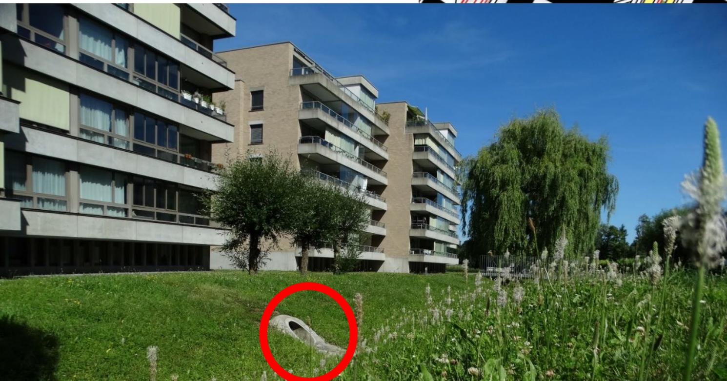
→ le fossé pourrait être beaucoup moins profond si la conduite d'évacuation des eaux pluviales débouchait au niveau du rez-de-chaussée et non sous la dalle de l'immeuble
