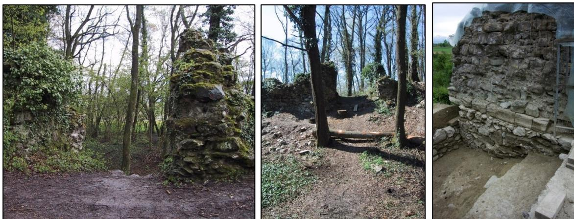
**Fig. 78** Vue de la porte du château avant dégagement de la végétation. A dr.: le montant de la porte montrant les fondations avec une assise de molasse. Photo: M. Delley.
