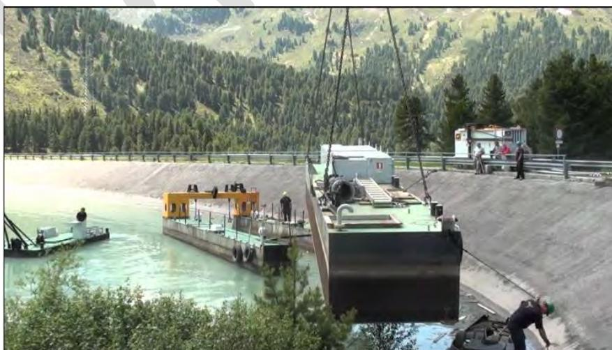
Figure C4 : Drague mis en place par grue sur une barge dans le réservoir de Längental, Autriche
