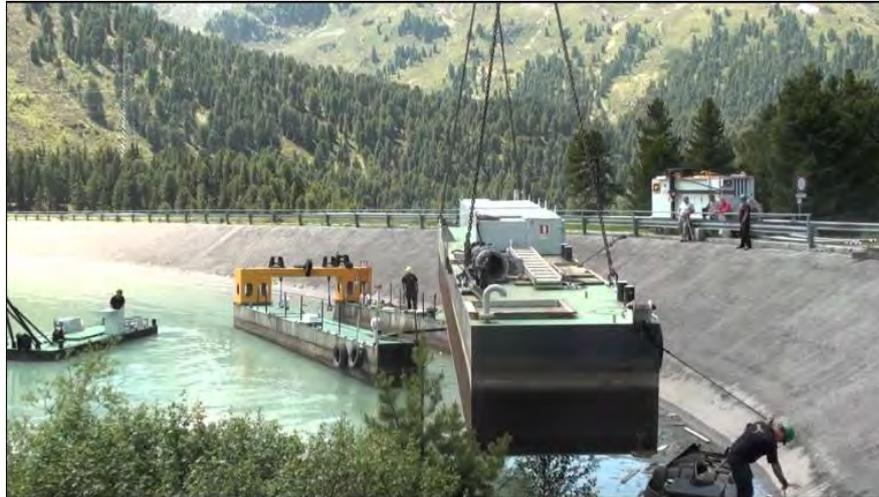
**Figure B7 : Drague mis en place par grue sur une barge dans le réservoir de Längental, Autriche**
