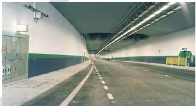
**Figure 17 : Medway Tunnel (UK) montrant panneaux de distribution électrique et sorties d'urgence**
