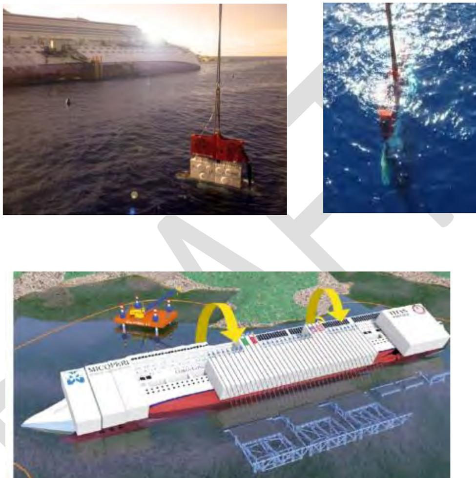
**Figure B4 : Images de l'installation des palplanches pour la récupération de la Costa Concordia**
