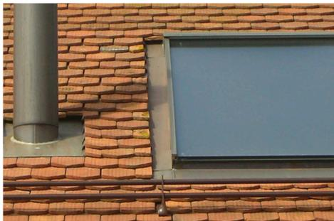
Détail d'une pose affleurée dans une toiture de tuiles :
