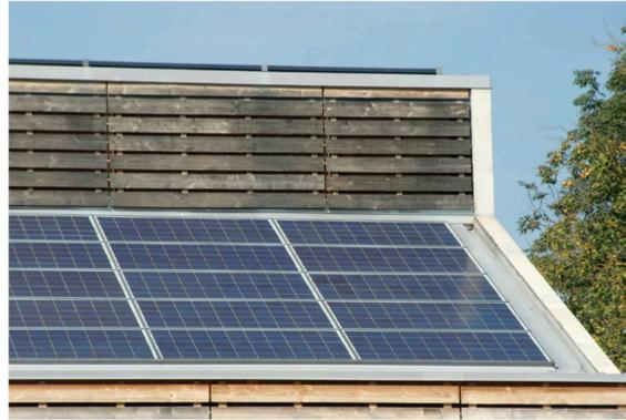
La pose de panneaux solaires photovoltaïques sur un pan entier d'un toit peut être envisagée lorsque la recherche d'intégration architecturale est particulièrement étudiée.
