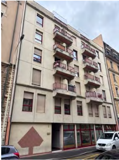
VUE DEPUIS LE SUD-EST
